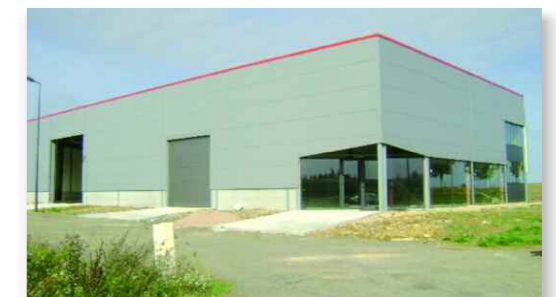
Vue du local en construction de l'entreprise Nicolas Hainaux
