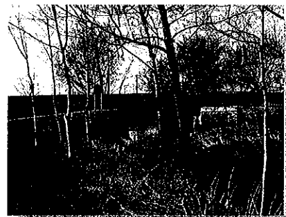
« Pont enjambant l'Othain réhabilité par la CODECOM »
