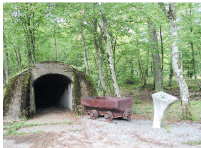
Tunnel de Duzey
