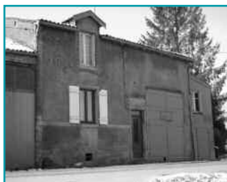
Les logements de Gouraincourt avant réhabilitation
